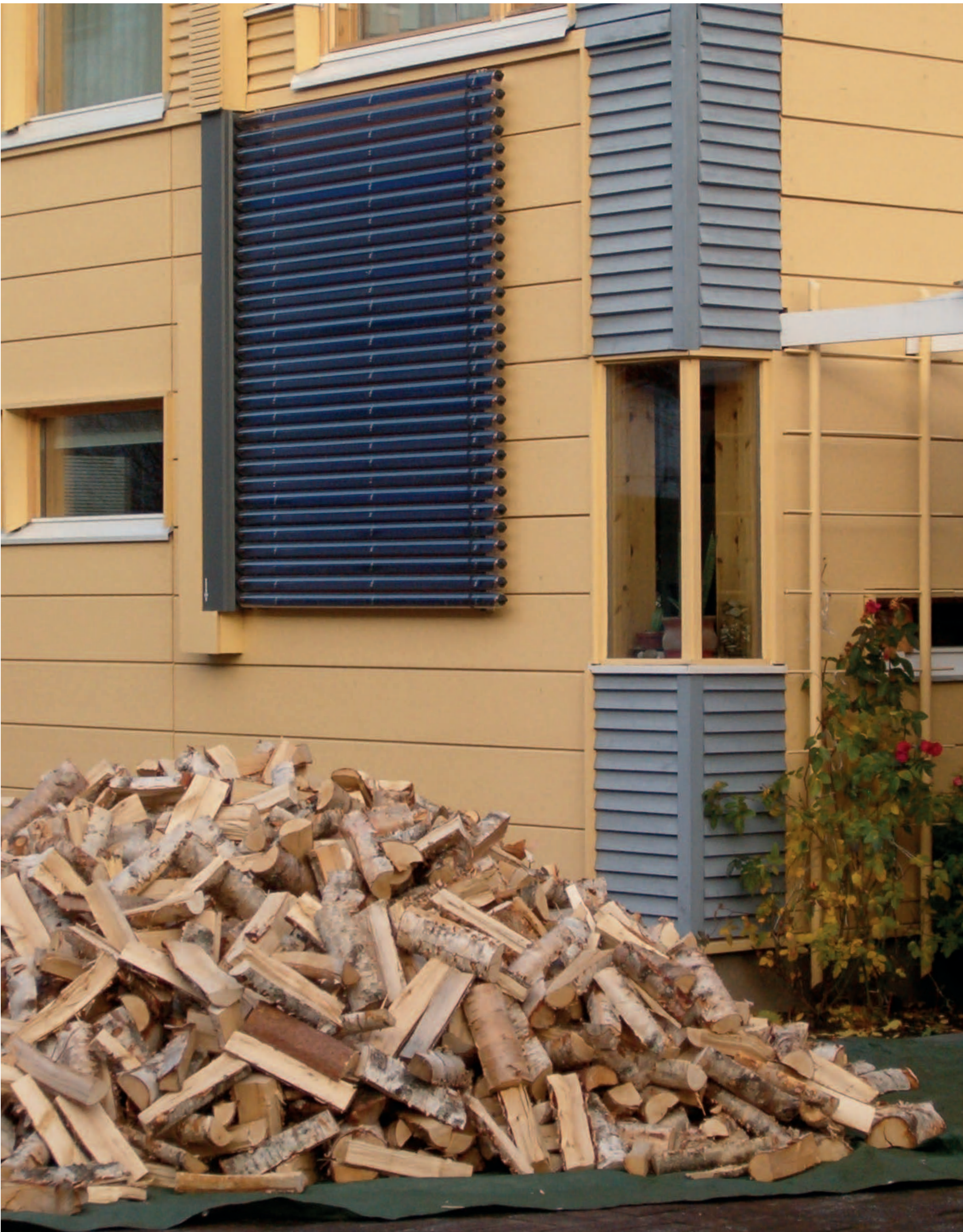
太陽熱と薪を組み合わせた暖房は環境に優しい住宅暖房である。 Combined solar and wooden heating is an environmentally sound way of heating a house.
